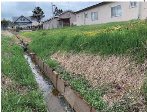
改善された排水路（勇足元町）
