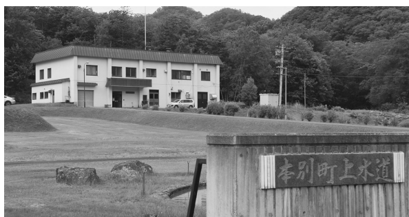
安全な水の供給を（本別浄水場）
