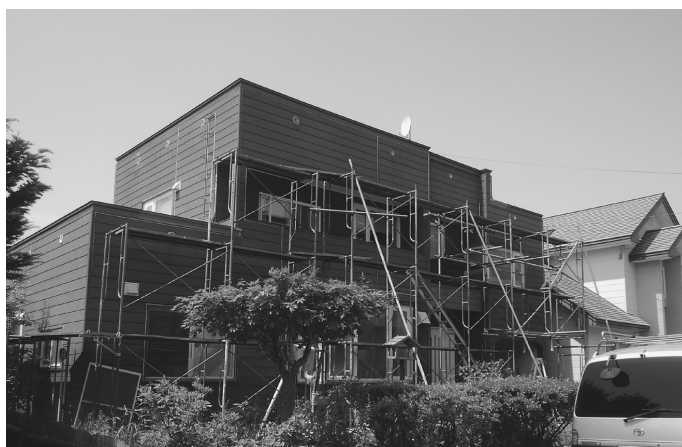
外壁をリフォームする住宅
