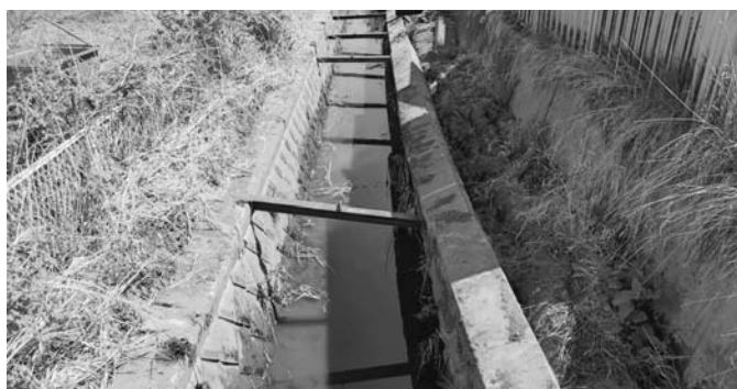
急がれる護岸改修！
