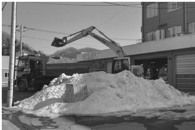
役場裏の排雪作業
