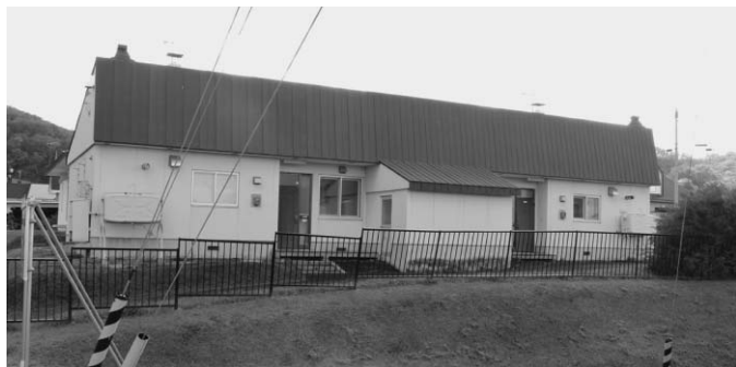
購入する旧保健所職員住宅
