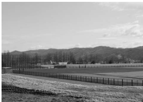
建設中の太陽の丘野球場
