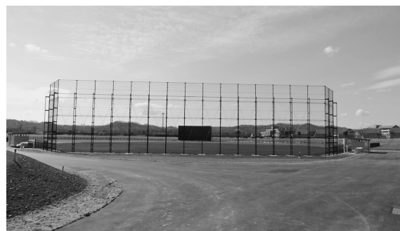
建設中の太陽の丘野球場
