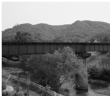
保存される本別川鉄橋
