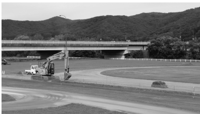
ウレタン舗装に整備中の河川敷グランド
