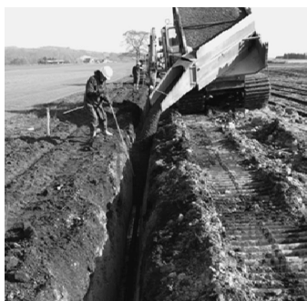
砂利暗渠施工中
