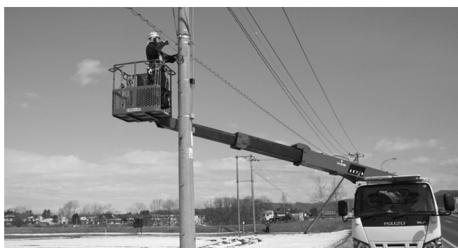
急ピッチで進む光ファイバーの設置
