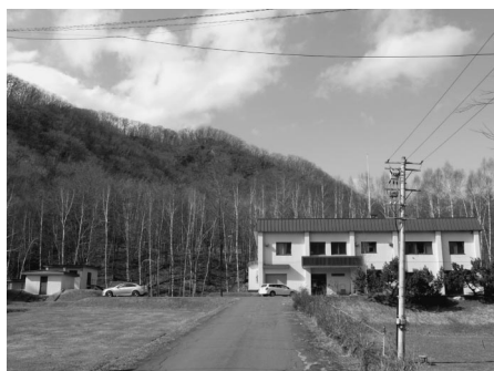
33年が経過した浄水場
