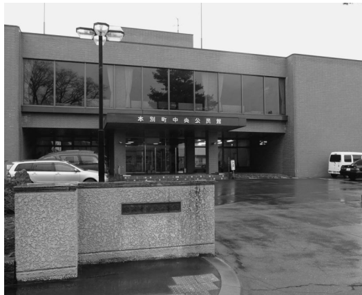
耐震補強される中央公民館
