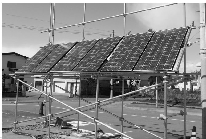
国と町が補助する太陽光パネル
