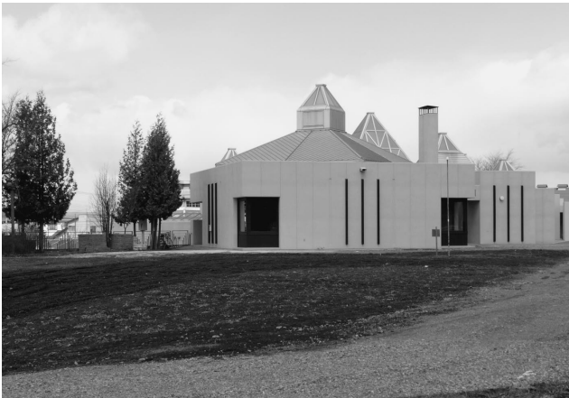
農産物加工施設の建設予定地（道の駅南側）
