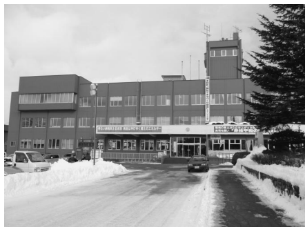
耐震補強工事を実施する役場庁舎
