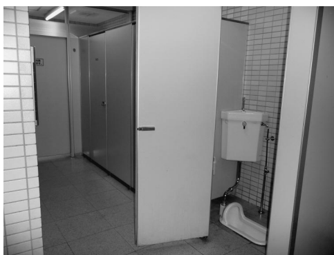
改修が待たれる道の駅トイレ
