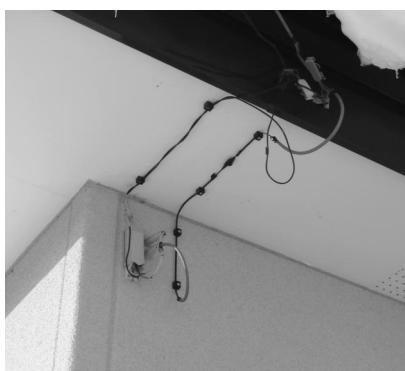
個人宅への光ケーブル架設
