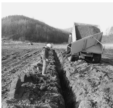
砂利暗渠の施工
