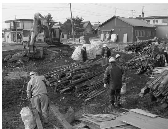
旧鉄道官舎（北5）の解体作業
