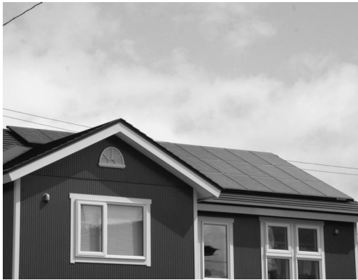
一般住宅に設置された太陽光パネル
