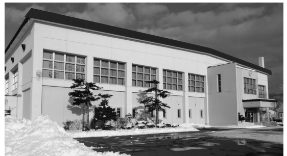
耐震補強する本中体育館
