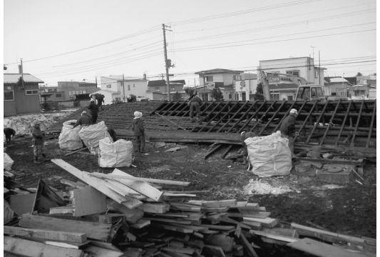
昨年実施した銀河線宿舎の解体工事
