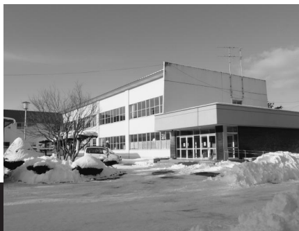
耐震補強する中央小学校
