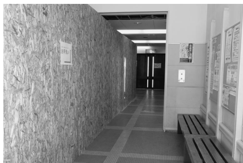
内装工事のため仕切られたステラプラザ内
