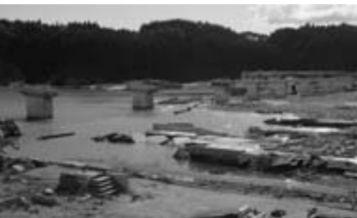
壊滅的な被害を受けた歌津地区の漁港と津波にさらわれ橋脚だけが残る国道45号線歌津大橋
