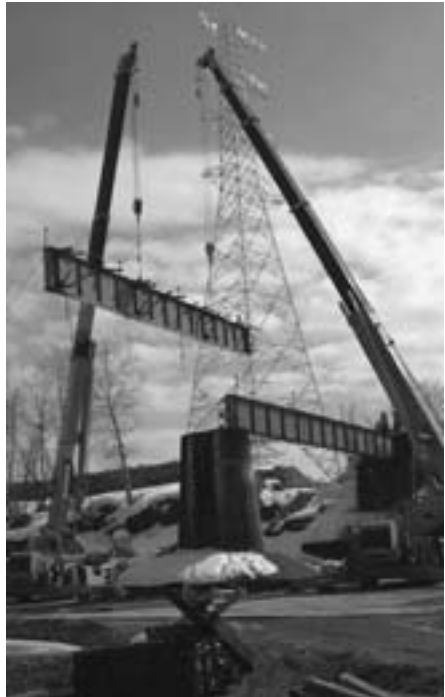
銀河線の鉄橋撤去も進んでいます
