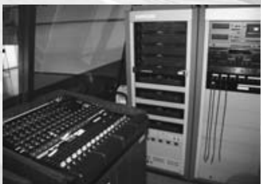
更新される中央公民館大ホールの音響設備
