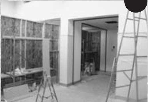
改装が進むステラプラザ(旧本別駅)内
