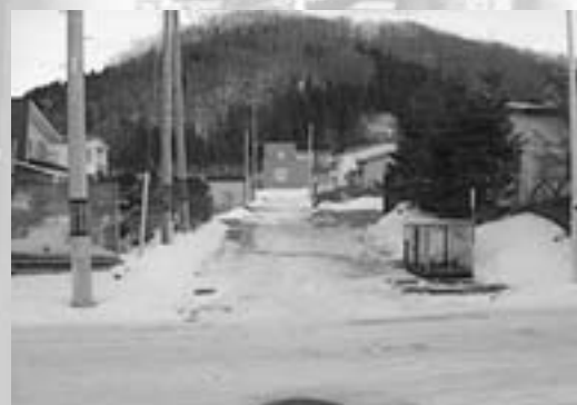
改良舗装工事が施される町道柏木町8号通り
