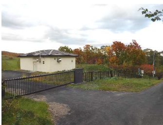
西美里別第1配水池
