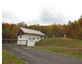
美里別配水池
