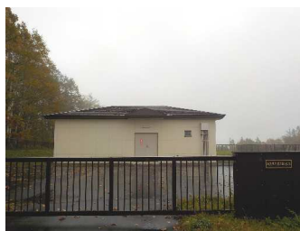
西美里別第2配水池
