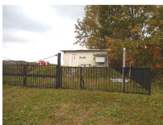
導水ポンプ場
