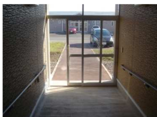
◆朝陽の里団地 ・共用玄関（手摺り）
