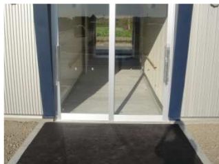
◆栄町団地（木平棟） ・共用玄関（段差無し）
