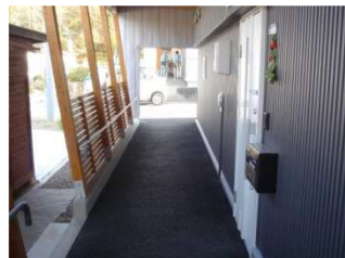
◆向陽町団地（簡平リモデル棟） ・雁木（手摺り、フラットな通路）
