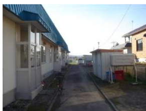
◆錦町団地（簡平棟） ・物置（駐車スペースは無い）
