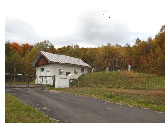
美里別配水池
