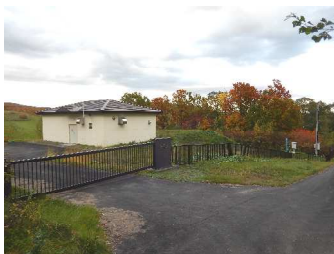
西美里別第1配水池
