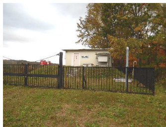
導水ポンプ場
