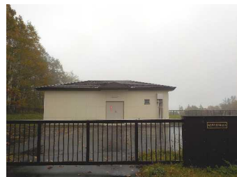
西美里別第2配水池
