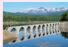
タウシュベツ川橋梁
